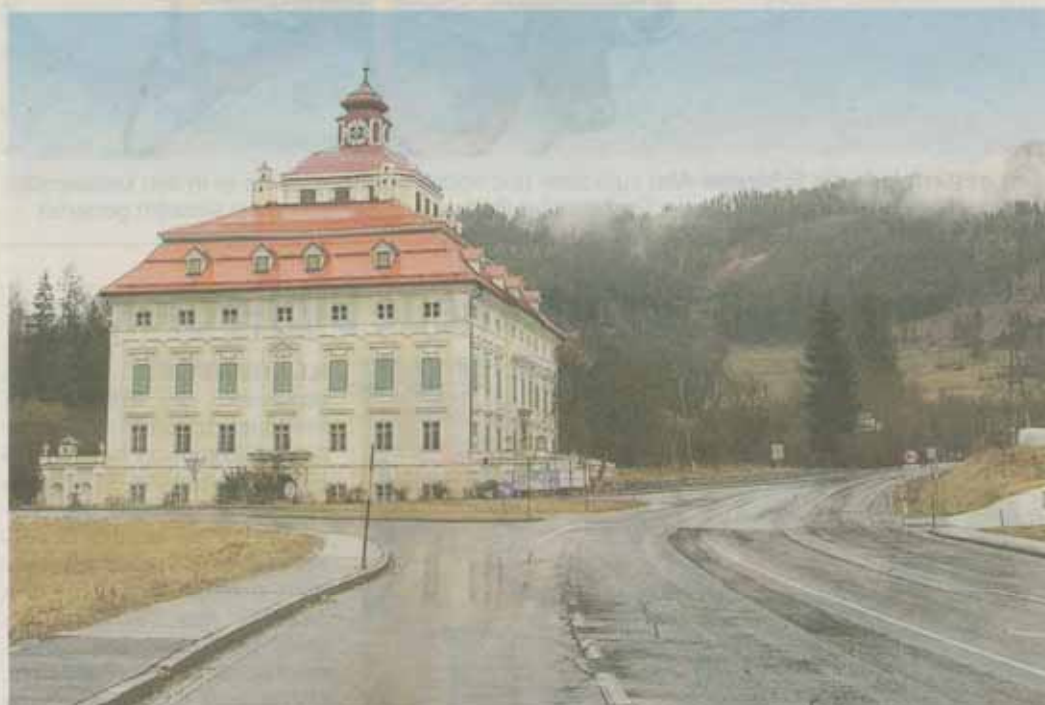
Das Nadelöhr bei Pöckstein würde beim S-37-Ausbau verschwinden. Die Demonstranten befürchten den Wegfall der 7,5-Tonnen-Beschränkung und damit eine Zunahme des Schwerverkehrs.
